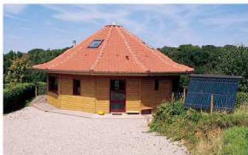
En ossature bois, la structure de la maison est en sapin du nord de Scandinavie, issu de plantations respectant l'écologie. Le bardage est en sapin thermo-traité. Les menuiseries en aluminium sont thermolaquées en bordeaux.
